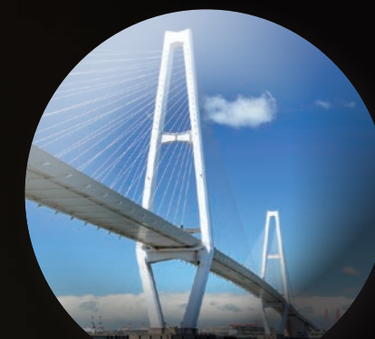
测量示例3 桥梁的接合部
